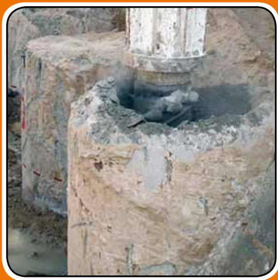
Une ER 1500-3 L détruisant des piles à DUBAI.
